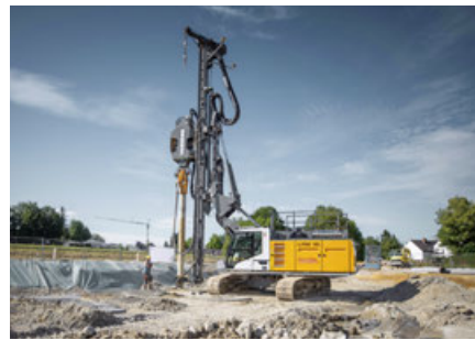
深基础施工设备
