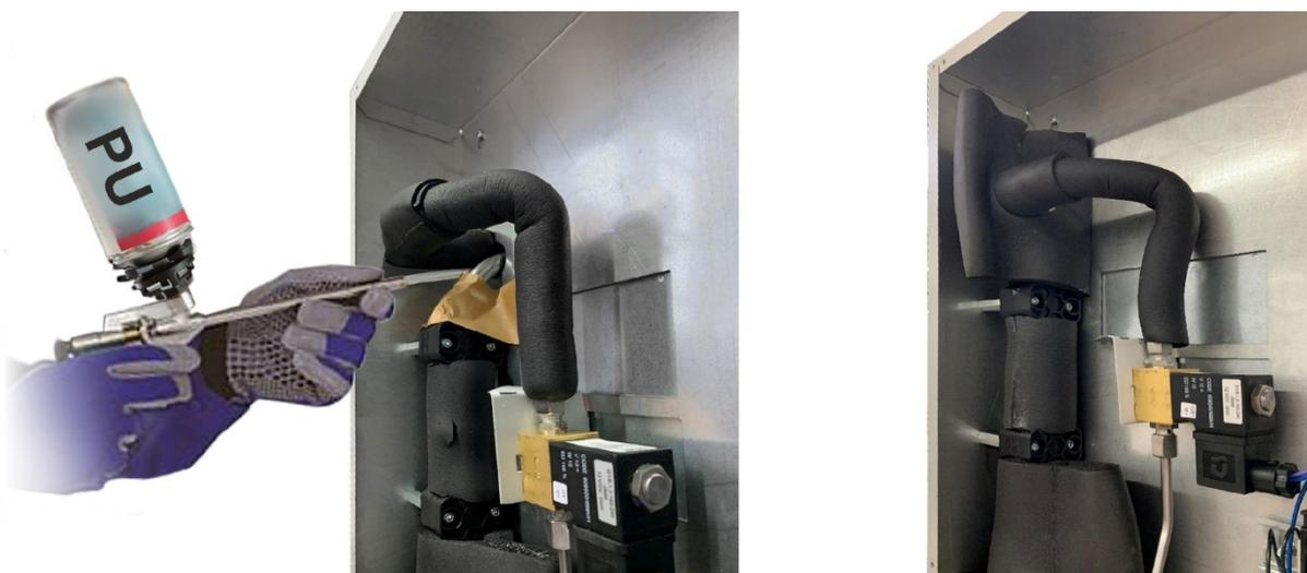
25. Schneiden Sie mit einem Messer nach ca. 20 Minuten den übergequollenen PU-Schaum ab.
